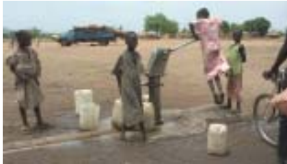
UNHCRが修復したポンプ（スーダン南部） UNHCR / Y. Moriya
