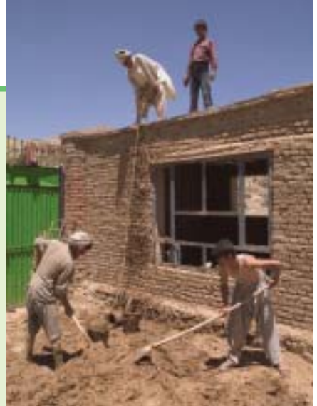
日干しレンガを使った家の再建作業。 UNHCR / N. Behring
