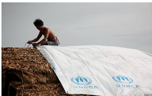
【写真上】 UNHCRのビニールシートで 屋根を修理する被災者
